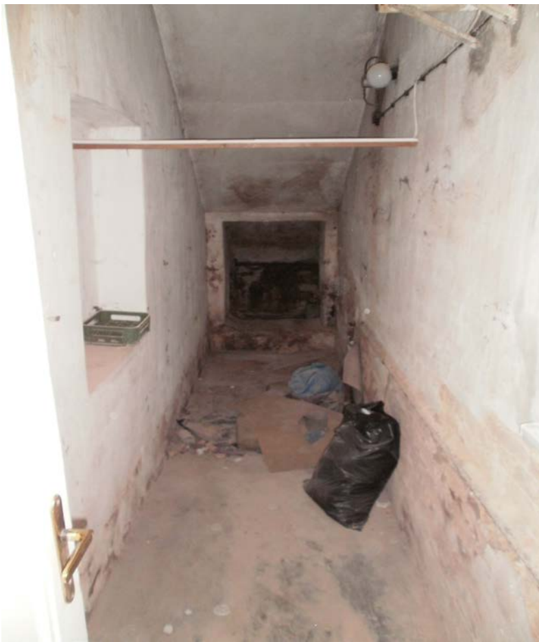
Foto č. 2 - Oprava podschodišťového prostoru v hlavní budově
