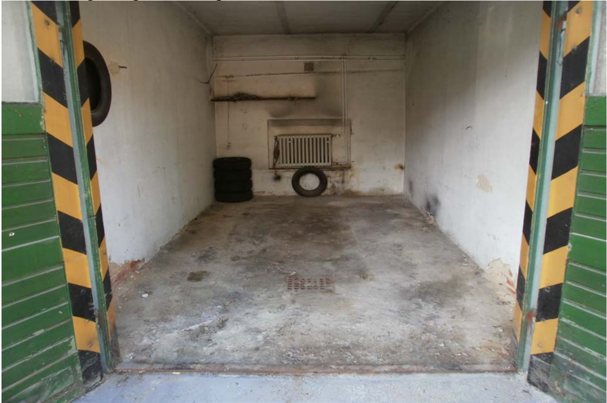
Foto č. 1 - Oprava garáže v hospodářské budově
