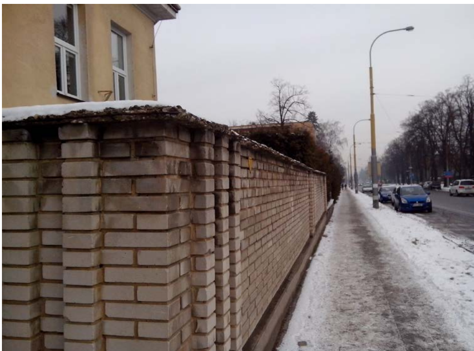
Foto č. 4 - Oprava zděného plotu u hlavní budovy
