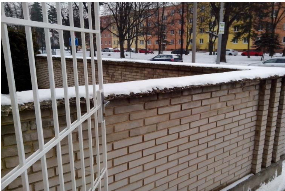
Foto č. 3 - Oprava zděného plotu u hlavní budovy
