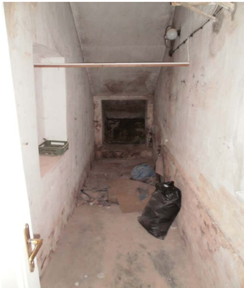
Foto č. 2 - Oprava podschodiš'ového prostoru v hlavní budově
