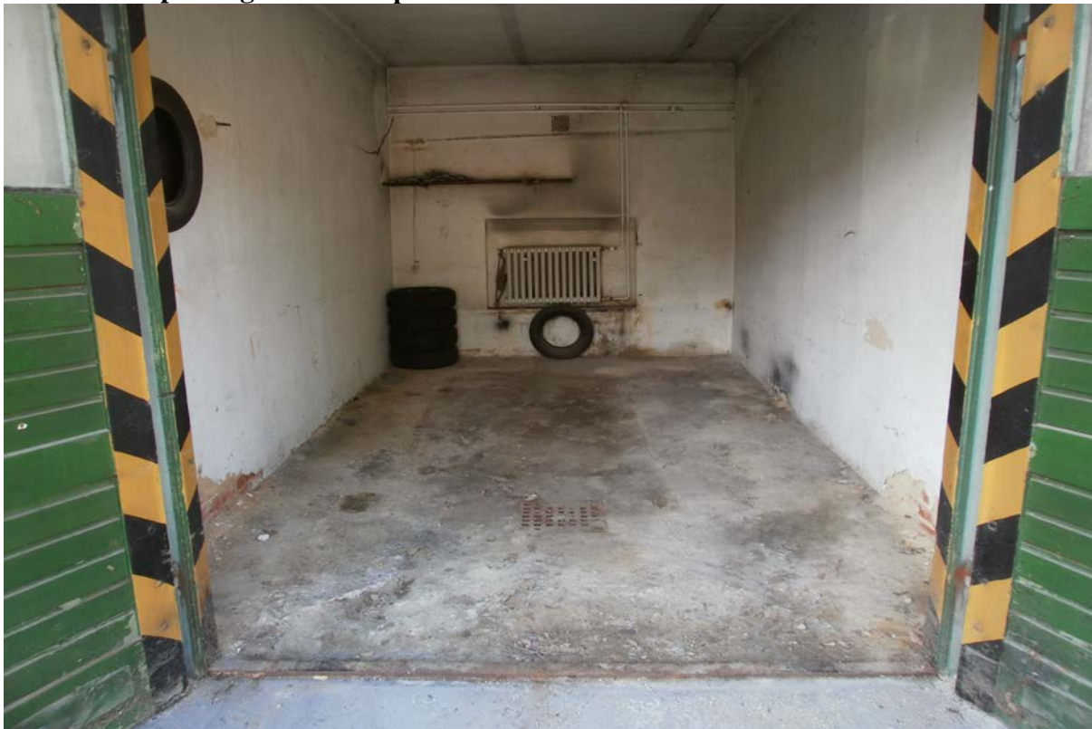
Foto č. 1 - Oprava garáže v hospodářské budově
